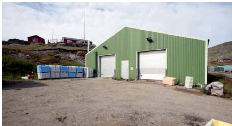
Unscheinbar steht das Gebäude des Greenland Brewhouse im Hafengebiet von Narsaq. In den blauen und weissen Boxen wird das Eis angeliefert.
